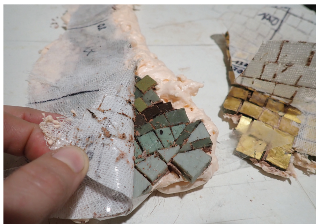
4. kép. A poliuretán ragasztóhab segítségével az üreg felől megtámasztott lógó részletek egyben tartott szakaszai. Az előoldali átragasztás ellenállás nélkül lefejthető volt a bevonat anyagával telített mozaikfelületről
