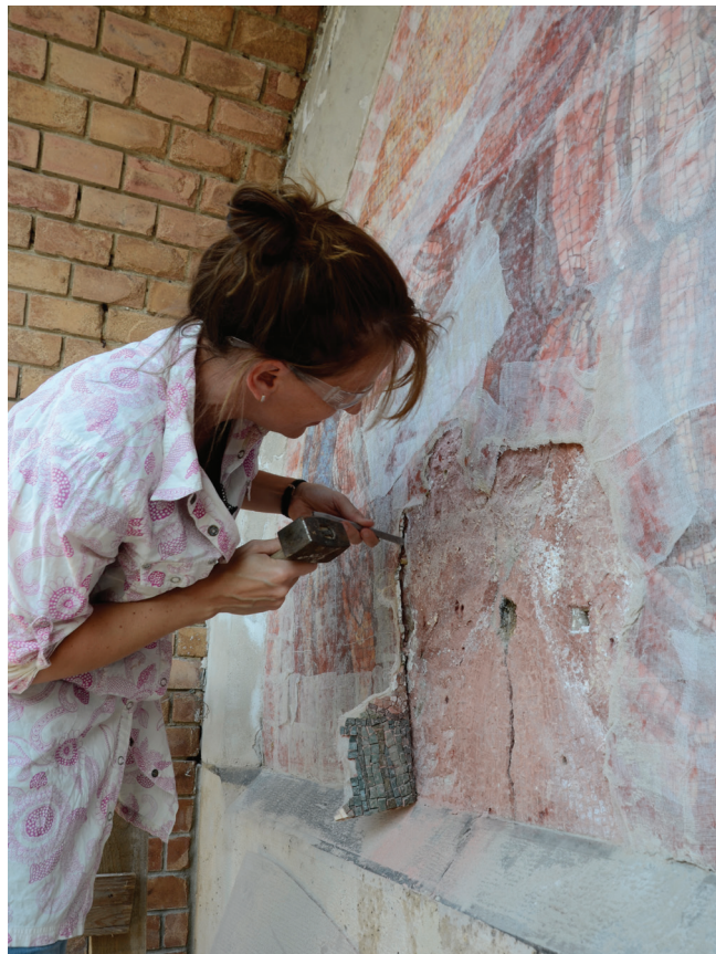
6. kép. Az átragasztott mozaik leválasztása, vídiás véső és kalapács segítségével, a már lebontott terület irányából indult
