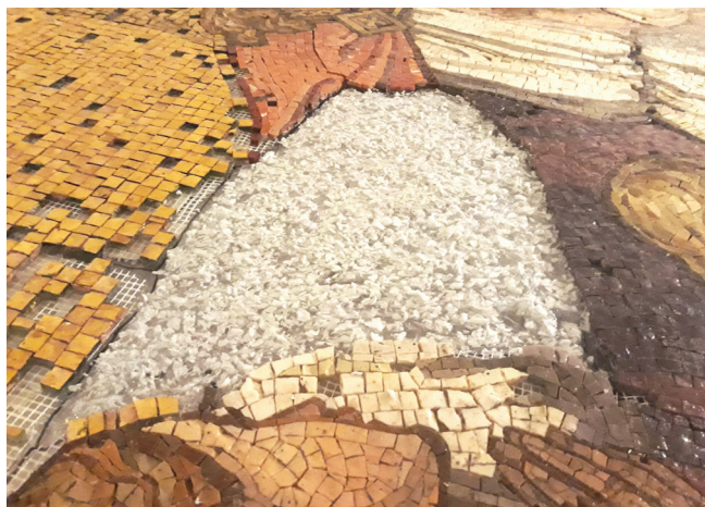
13. kép. Az előkészített mozaikszakaszok felragasztása a polikarbonát panel felületére felvitt elválasztó rétegre történt
