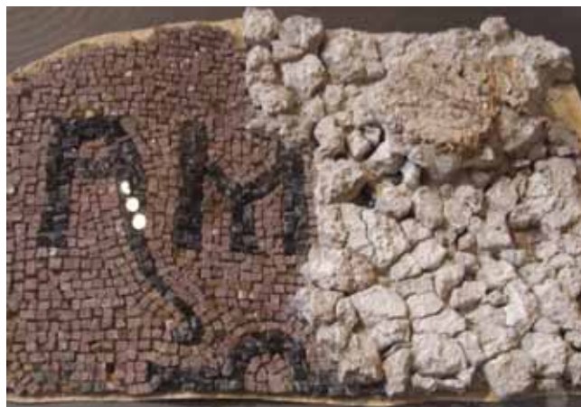
6. kép. Leválasztott mozaikrészlet hátoldala. A tesseraék hátán több rétegű vakolat töredékei mutatják a rétegfelépítést. Velence, Szent Márk Bazilika állandó kiállítása.
